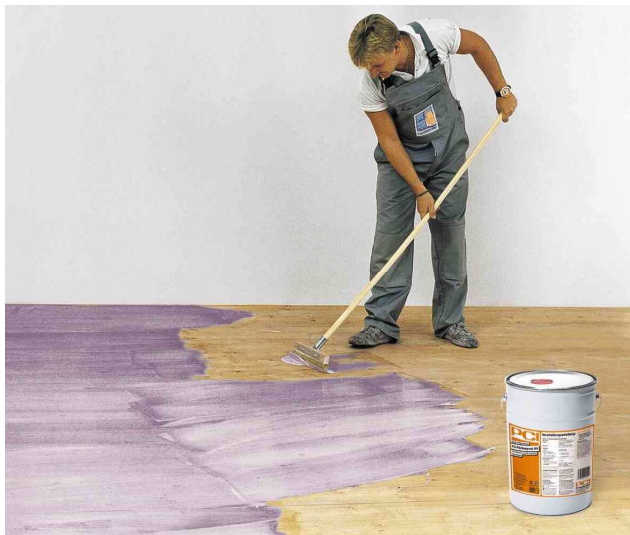
PCI Gisogrund 404 фиолетового цвета для контроля грунтовки обеспечивает высокую прочность сцепления выравнивающих смесей и покрытий к соответствующему основанию.
