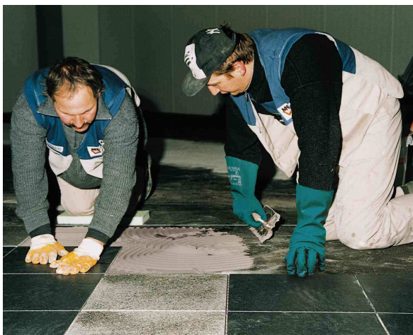
Надежная укладка плит из натурального камня средним слоем с помощью PCI® Carrament.
