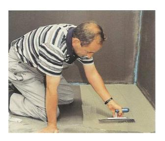
Благодаря добавлению PCI Lastoflex плиточный клей компенсирует температурные колебания и напряжения основания.
