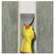
Перед нанесением ленты Sikadur® -Combiflex® SG снимите защитную полосу с деформационного шва / трещины.
