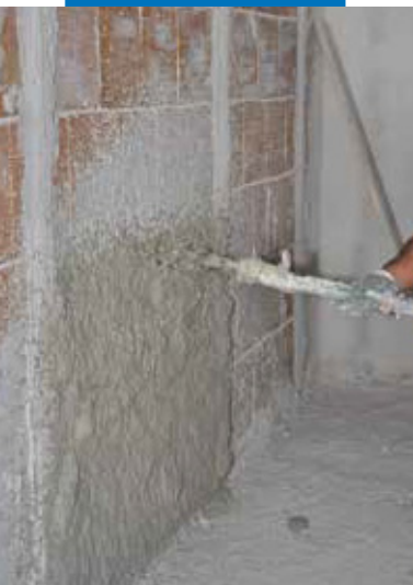
Нанесение Intomap 340 набрызгом
