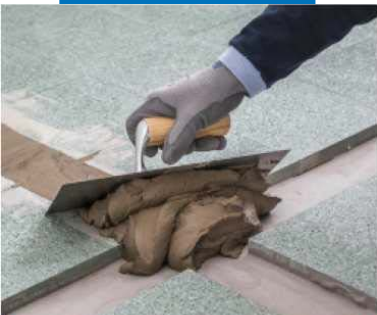
Заполнение мест прокладки кабеля с помощью Планипатч
