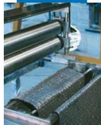
Impregnazione a macchina di MapeWrap C
