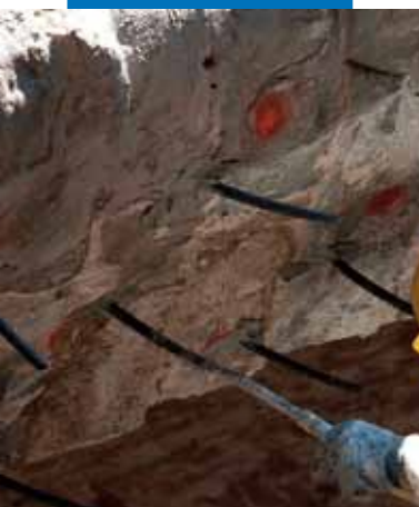
Инъекция Mape-Antique F21 в каменную кладку
