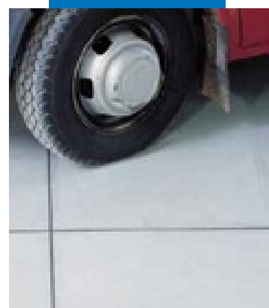
Эксплуатируемый шов, загерметизированный Mapeflex PU21
