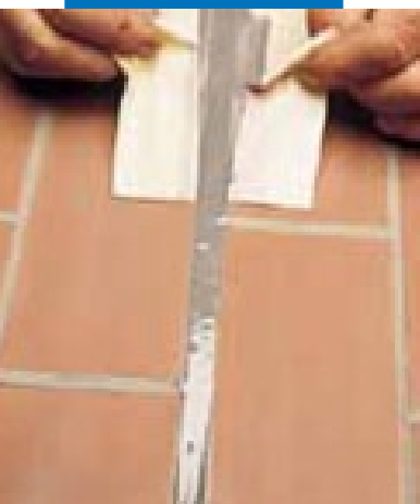
Компенсационный шов, загерметизированный Mapeflex PU21
