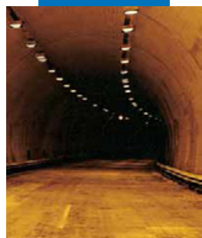
Нанесение белого Planiseal 88 напылением в автодорожной галерее
