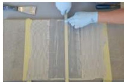
Нанесите эпоксидный клей на поверхность. Он должен выступать за края ленты на 2-3 см.
