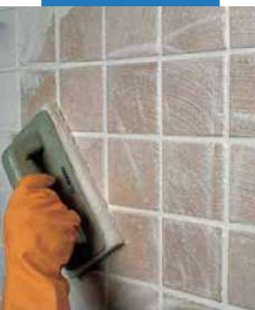
Очистка плитки одинарного обжига абразивным падом
