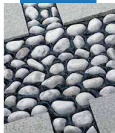
Пример заполнения швов пола с каменным орнаментом
