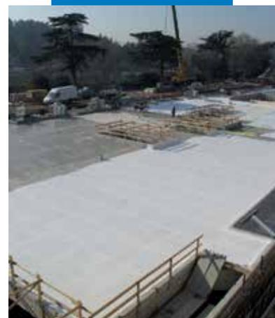
Обустройство гидроизоляции подземного паркинга с Purtop 600
