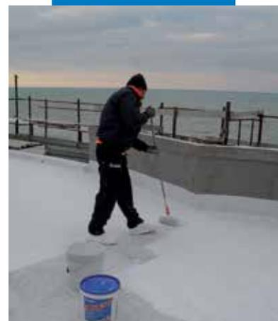
Нанесение валиком Triblock P на бетонную поверхность
