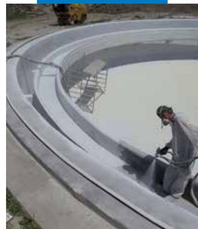
Нанесение Purtop 1000 на поверхность гидротехнических резервуаров
