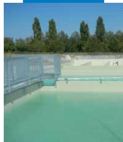
Гидротехнический резервуар с гидроизоляцией Purtop 1000
