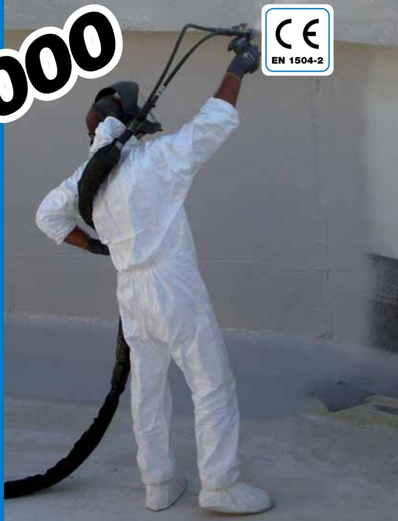
**Двухкомпонентная, не содержащая растворителей мембрана из чистой полимочевины, которая наносится способом распыления под высоким давлением при помощи двухкомпонентного насоса. Материал формирует гидроизоляционное покрытие непосредственно на месте. Применяется для гидроизоляционных работ, гидроизоляции кровель и мостовых конструкций.**
