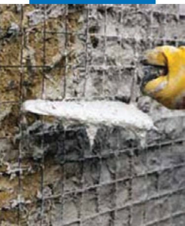
Нанесение Mape-Antique Rinzafto на слабую кладку
