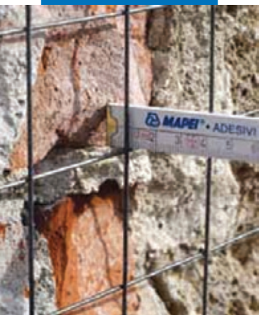
Проверка зазора между сеткой и основанием
