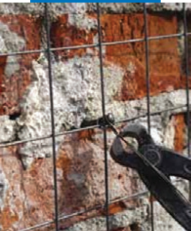
Фиксация оцинкованной сетки на кладке
