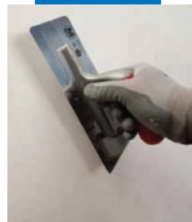
Нанесение второго слоя Mape-Antique FC Ultrafine
