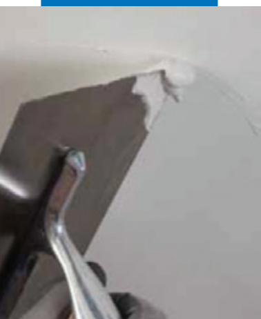
Выравнивание материала гладким металлическим шпателем
