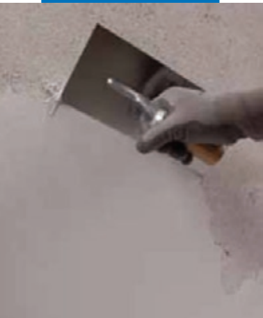
Нанесение первого слоя Mape-Antique FC Ultrafine
