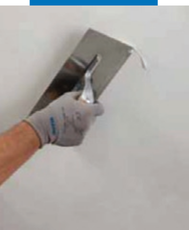
Этап нанесения Mape-Antique FC Ultrafine
