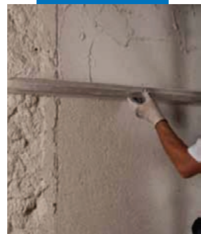
Выравнивание Mape-Antique MC Macchina с помощью правила
