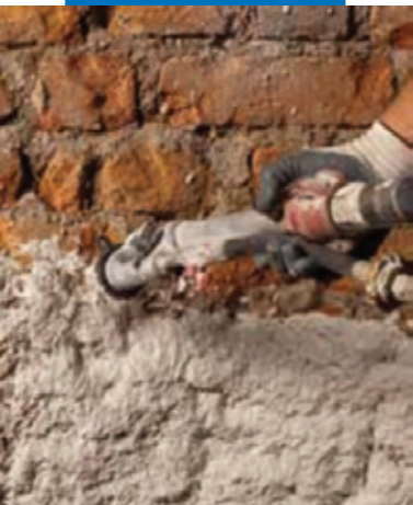
Нанесение Mape-Antique Rinzafo
