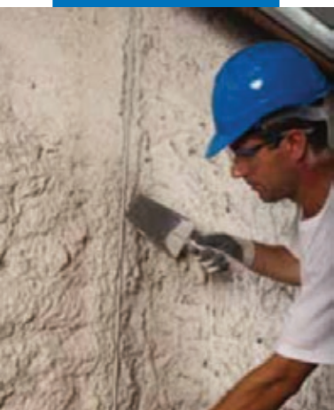
Установка вертикальной направляющей
