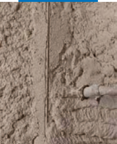
Нанесение Mape-Antique MC Macchina
