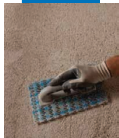
Заглаживание поверхности Mape-Antique MC Macchina
