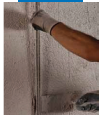
Удаление вертикальной направляющей
