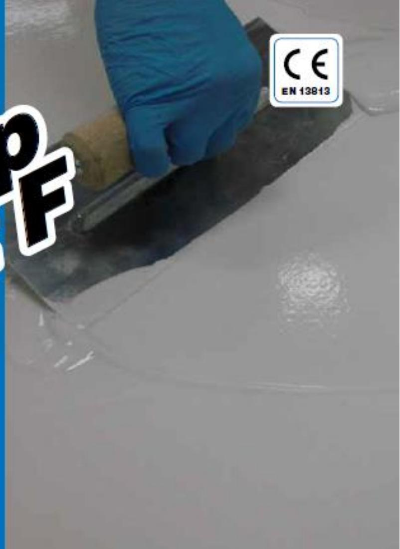
**Однокомпонентная, укладываемая шпателем, крупнозернистая цементная паста, наносимая слоем толщиной 2 мм, для создания декоративных полов с эффектом «следов шпателя» или «крапчатым» эффектом**
