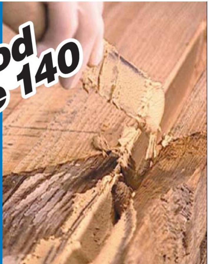
**Тиксотропный эпоксидный клей для восстановления деревянных структурных элементов.**
