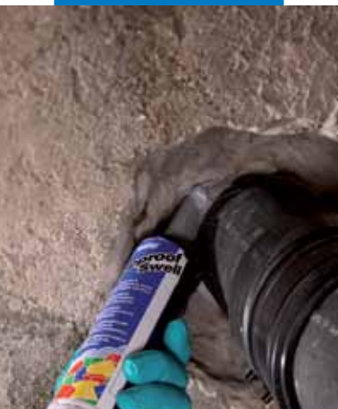
Герметизация элемента при помощи Mapeproof Swell
