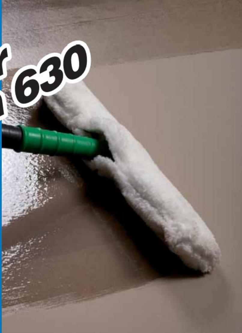
Двухкомпонентное, защитное акриловое пленкообразующее покрытие в водной дисперсии, для бетонных полов, Ultratop и Ultratop Living
