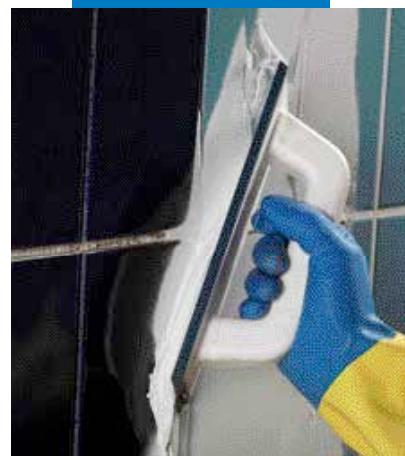
Нанесение Керапоху CQ на стену специальным шпателем MAPEI
