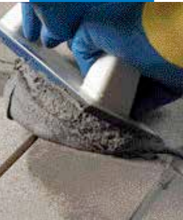
Нанесение Kerapoxy CQ с помощью шпателя MAPEI
